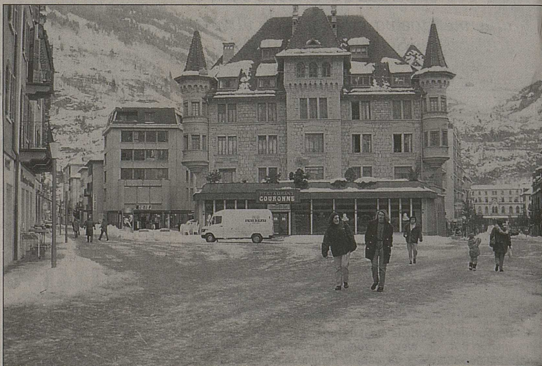
A Brigue, le barrage routier du centre de la ville sera commandé à distance.
