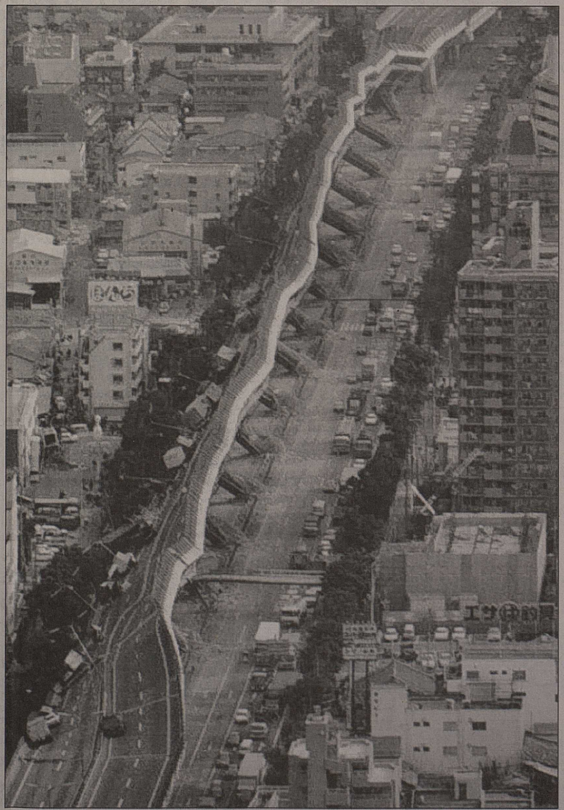
On les croyait à toute épreuve. Les autoroutes suspendues se sont couchées sur le flanc. keystone
