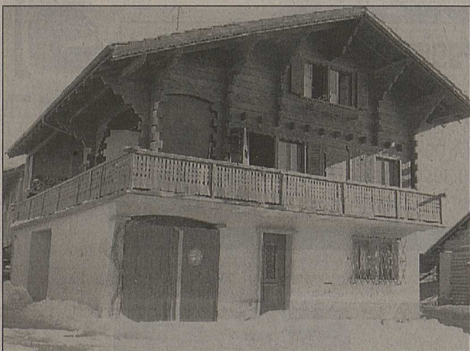
Le feu a pris à l'intérieur de l'appartement de Germain Francey.
