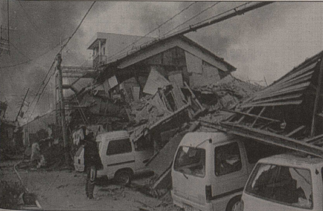
On estime à 4000 environ le nombre de bâtiments qui se sont effondrés. keystone
