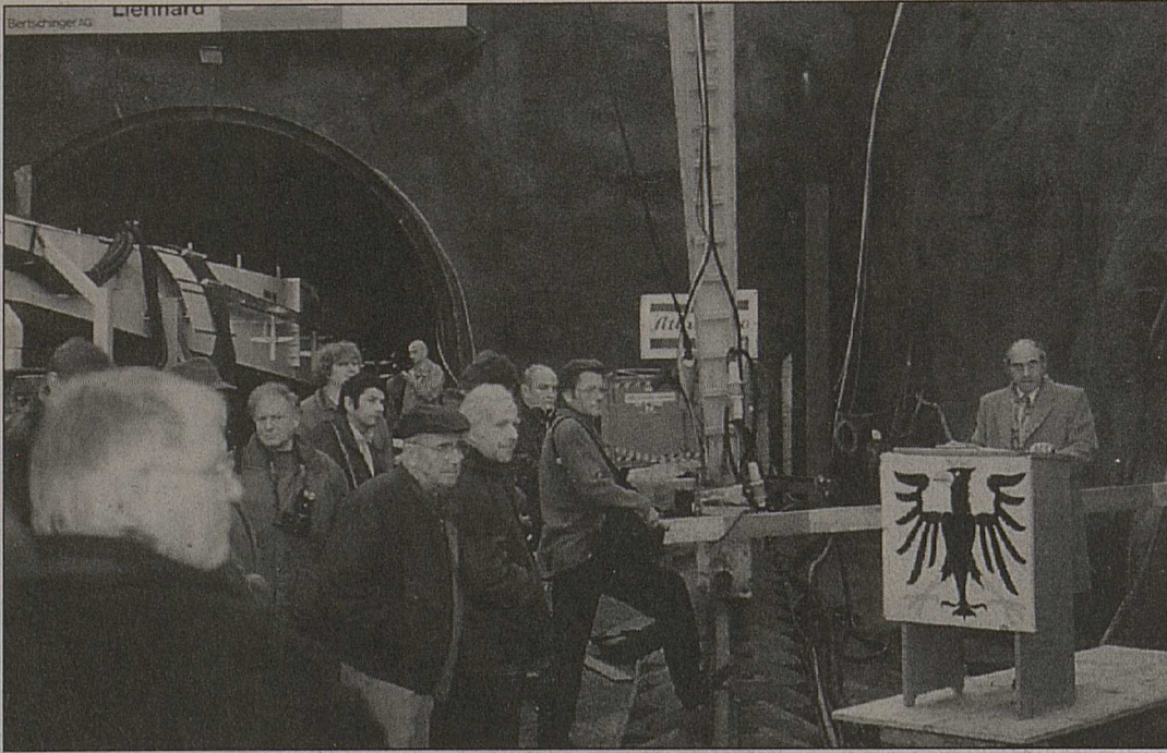
Décembre: inauguration du tunnel de sondage de la NLFA Lötschberg, à Frutigen.
