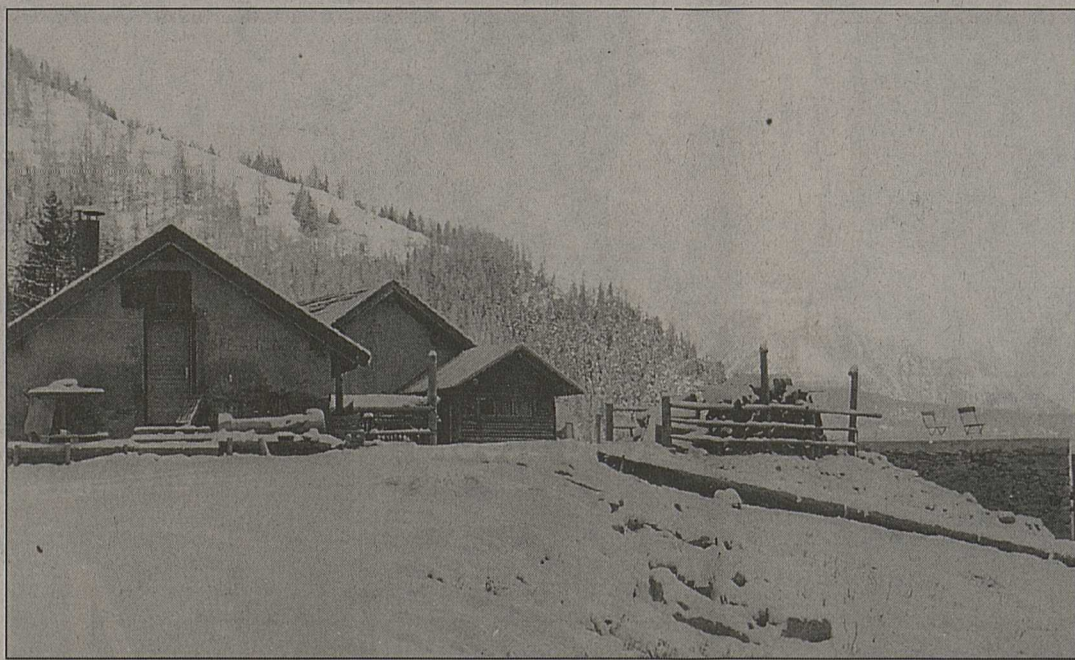
Le mayen du Plan-de-l'Alu après l'incendie. La chalet détruit se trouvait à droite du premier bâtiment.
