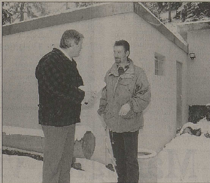
La nouvelle station de filtrage Filtrodeep, inaugurée mardi à Arbaz.
