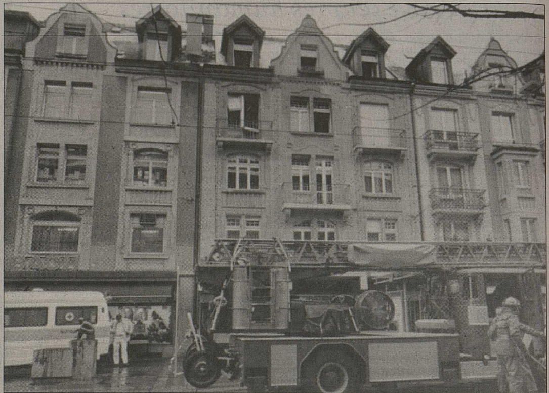
Au centre, l'immeuble théâtre du drame.
