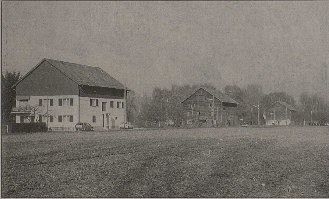
Hangars à tabac rattachés autrefois à l'exploitation de Tabac-Rhône S.A.
