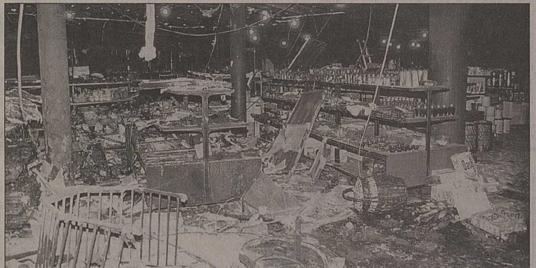
Les travaux d'inventaire et de nettoyage sont en cours dans le magasin incendié. Si le sous-sol a particulièrement souffert du feu, l'eau et la fumée ont provoqué d'importants dégâts dans les étages supérieurs. nt
