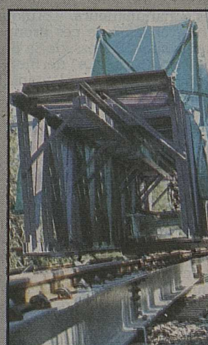
L'assemblage des voies.
