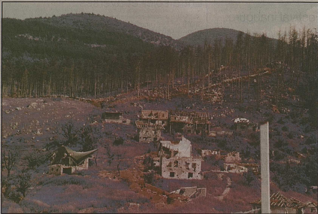
Maisons serbes détruites à Sarajevo. Les musulmans ont poussé leur offensive jusqu'aux tranchées à la lisière de la forêt.
