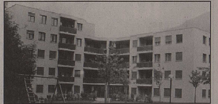
L'immeuble sis à la route des Iles comprend des appartements de quatre pièces et de deux pièces et demie, assurant une continuité de vie entre le bâtiment traditionnel et le home pour personnes âgées.
