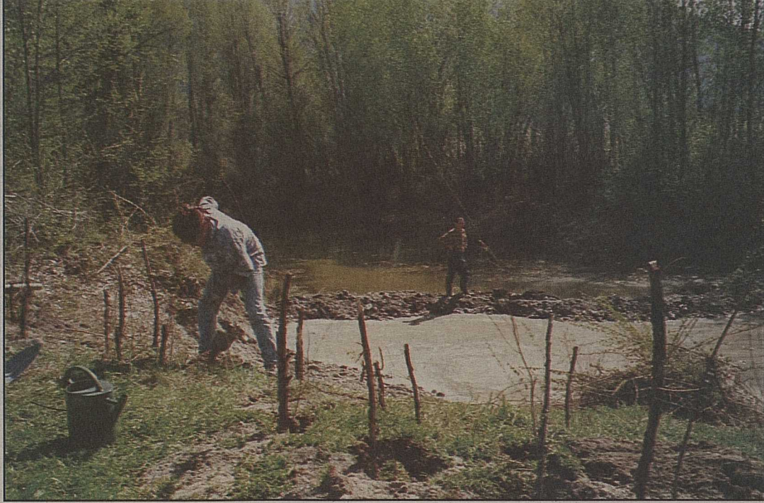
Plantation de boutures de saules pour protéger les gouilles nouvellement aménagées. c. schnydrig
