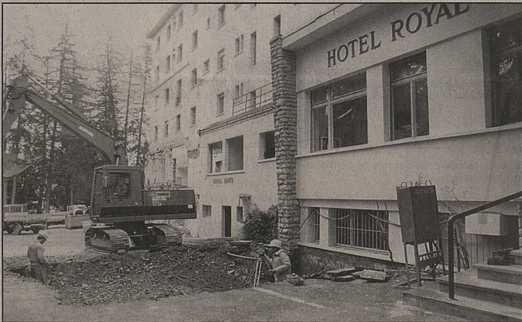
Situé à deux minutes de Crans et à cinq minutes des pistes, l'hôtel Royal subit actuellement d'importants travaux pour devenir un cinq-étoiles.
