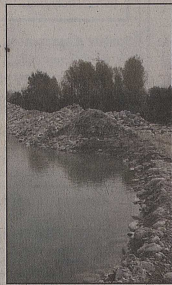
Des digues de dépôt de gravier au milieu du Rhône.
