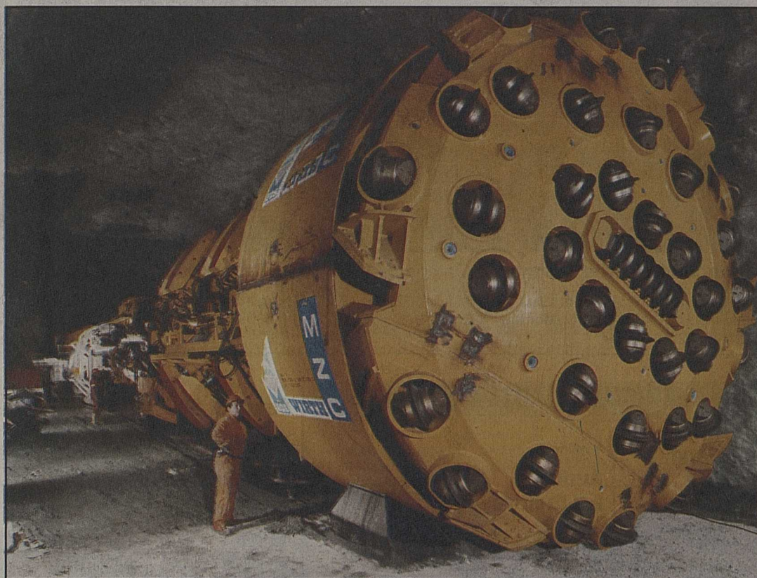
Le tunnelier du Chargeur (barrage de la Grande Dixence) a commencé hier à creuser la montagne. Il ressortira huit kilomètres plus loin, à Tortin.
