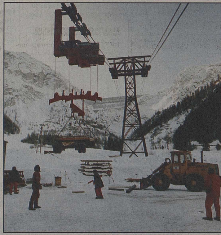
Deux grands téléphériques (comme celui-ci à Méribé) permettent d'accéder aux chantiers d'altitude.
