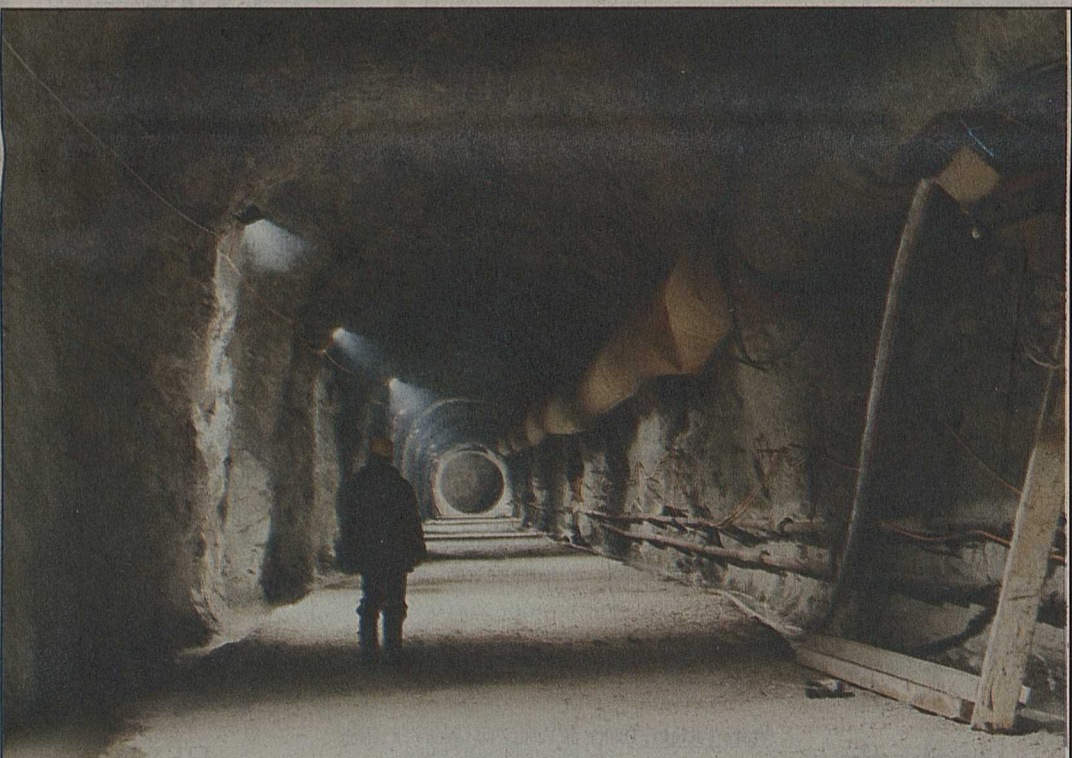
Dans la galerie d'amenée d'eau du Chargeur, un autre monde commence...
