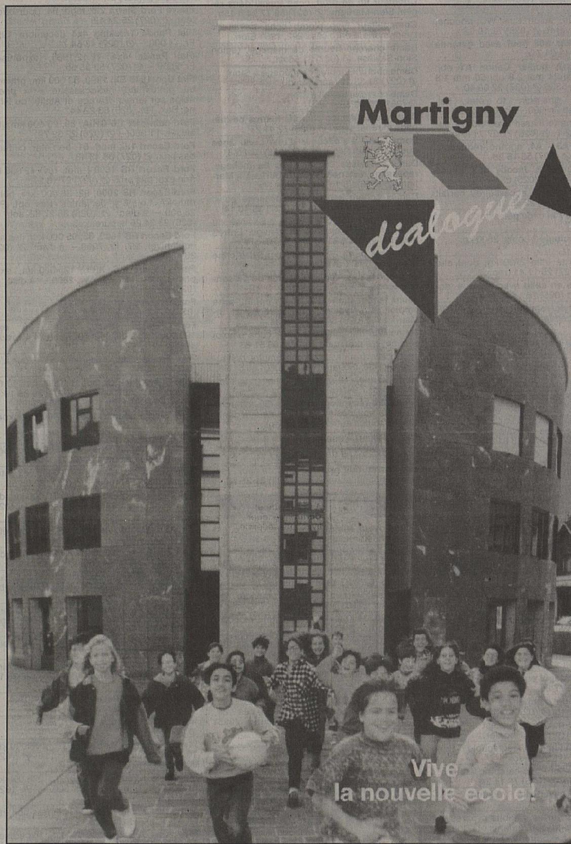
Le nouveau bâtiment des écoles du centre-ville de Martigny: en parfaite harmonie avec un environnement et une politique d'urbanisation sur mesure.
