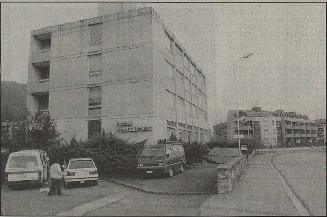
Les premières entreprises sont à pied d'œuvre.
