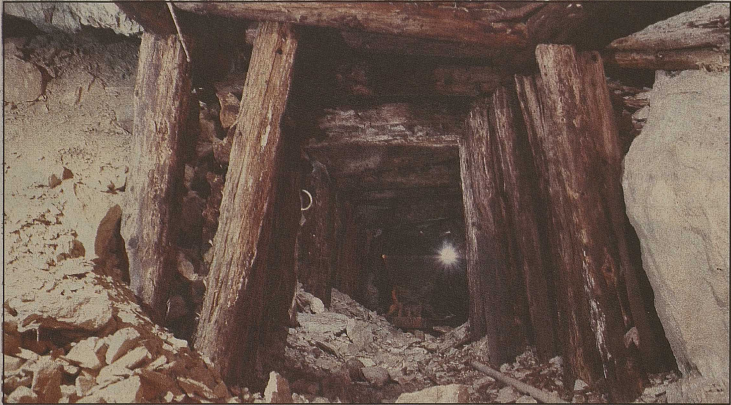
Cette entrée de mine à Mont-Chemin s'est effondrée il y a quelques années.
