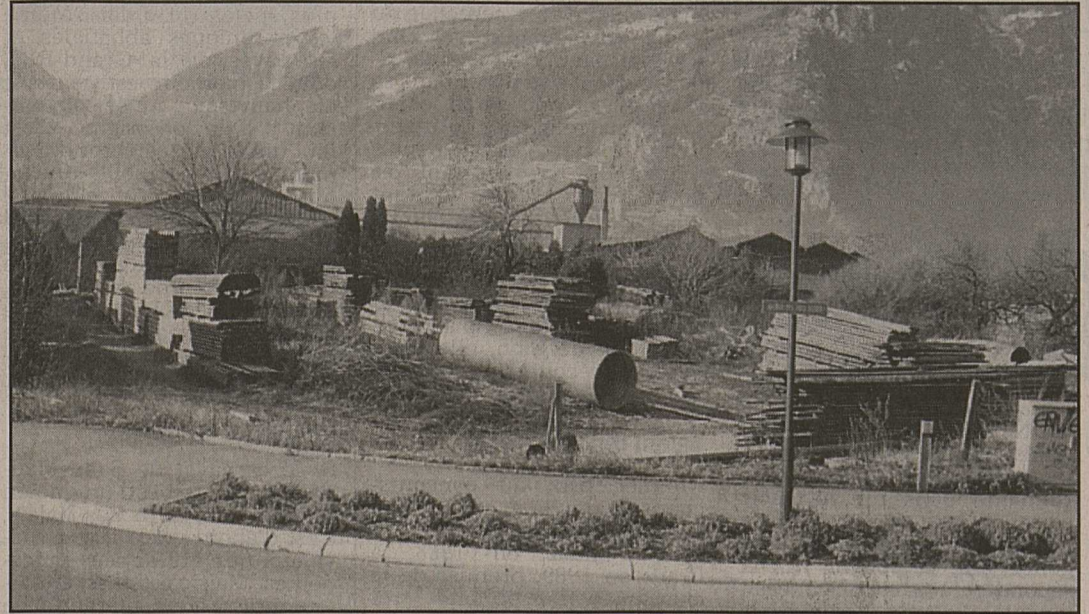
Les terrains de l'ancienne scierie Bompard vont bientôt accueillir un véritable quartier de logements sociaux.
