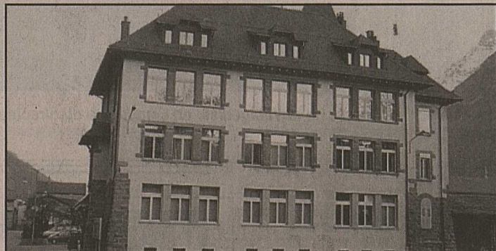
L'administration de Vernayaz devra attendre des jours meilleurs avant de procéder à une réfection du bâtiment communal.
