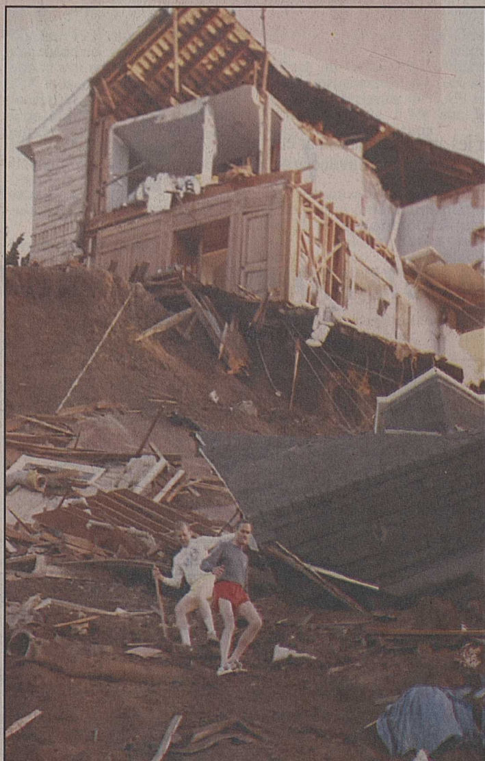
Ces deux habitants de Malibu visitent les ruines de leur habitation: le sol s'est littéralement dérobé sous elle.
