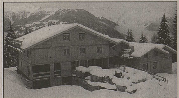
La première étape du complexe des Grands Ducs est désormais sous toit.
