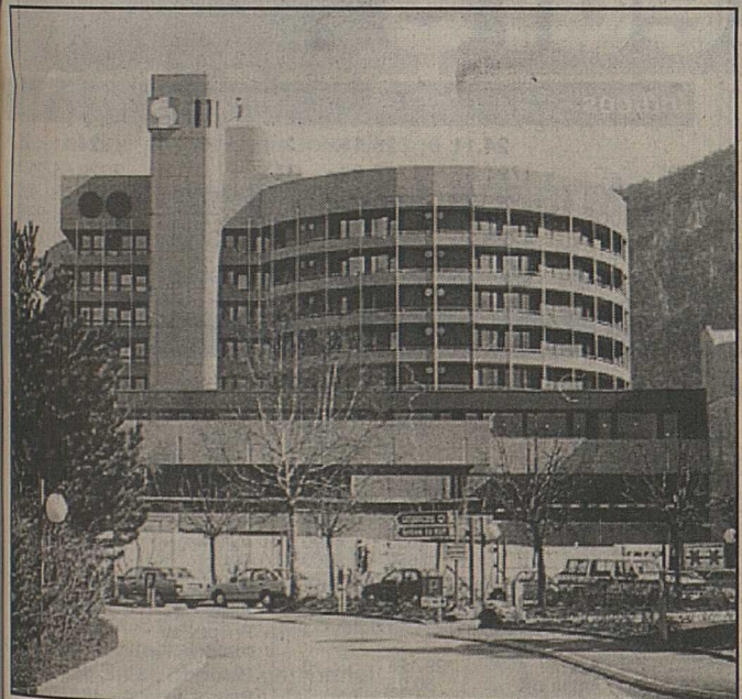
L'hôpital de Sion-Hérens-Conthey sera doté d'un service de chirurgie cardio-vasculaire, sous la forme d'une «chirurgie déléguée» du CHUV. nt
