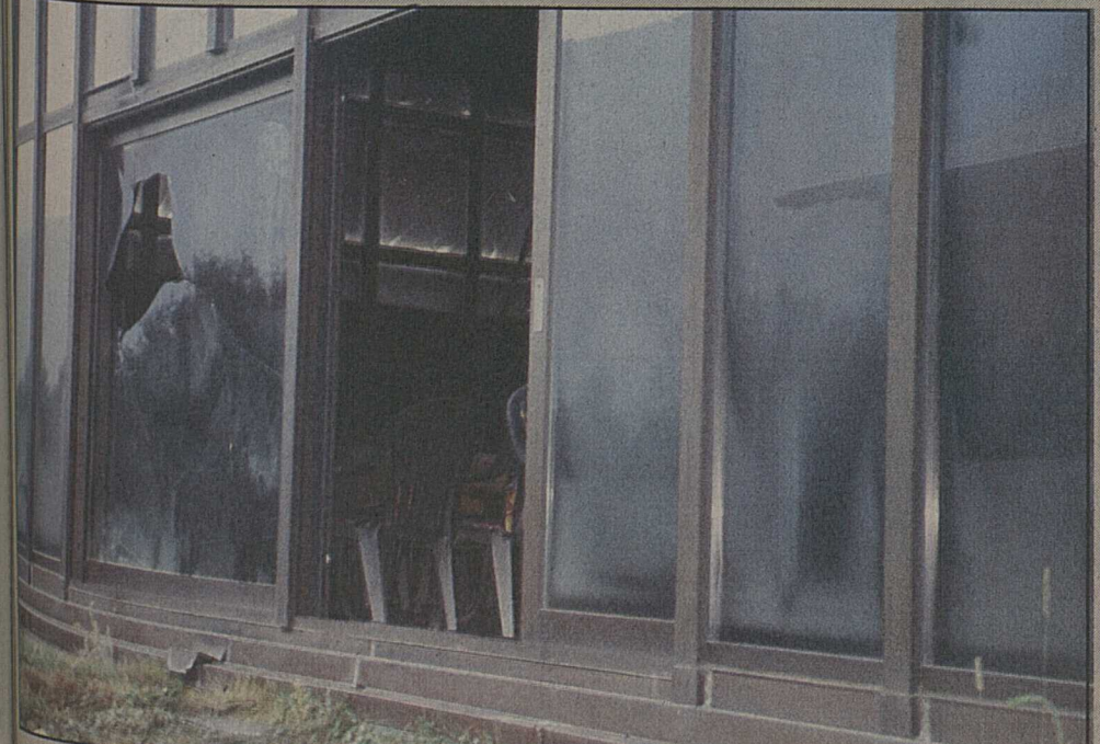
A l'intérieur, les dégâts sont importants.
