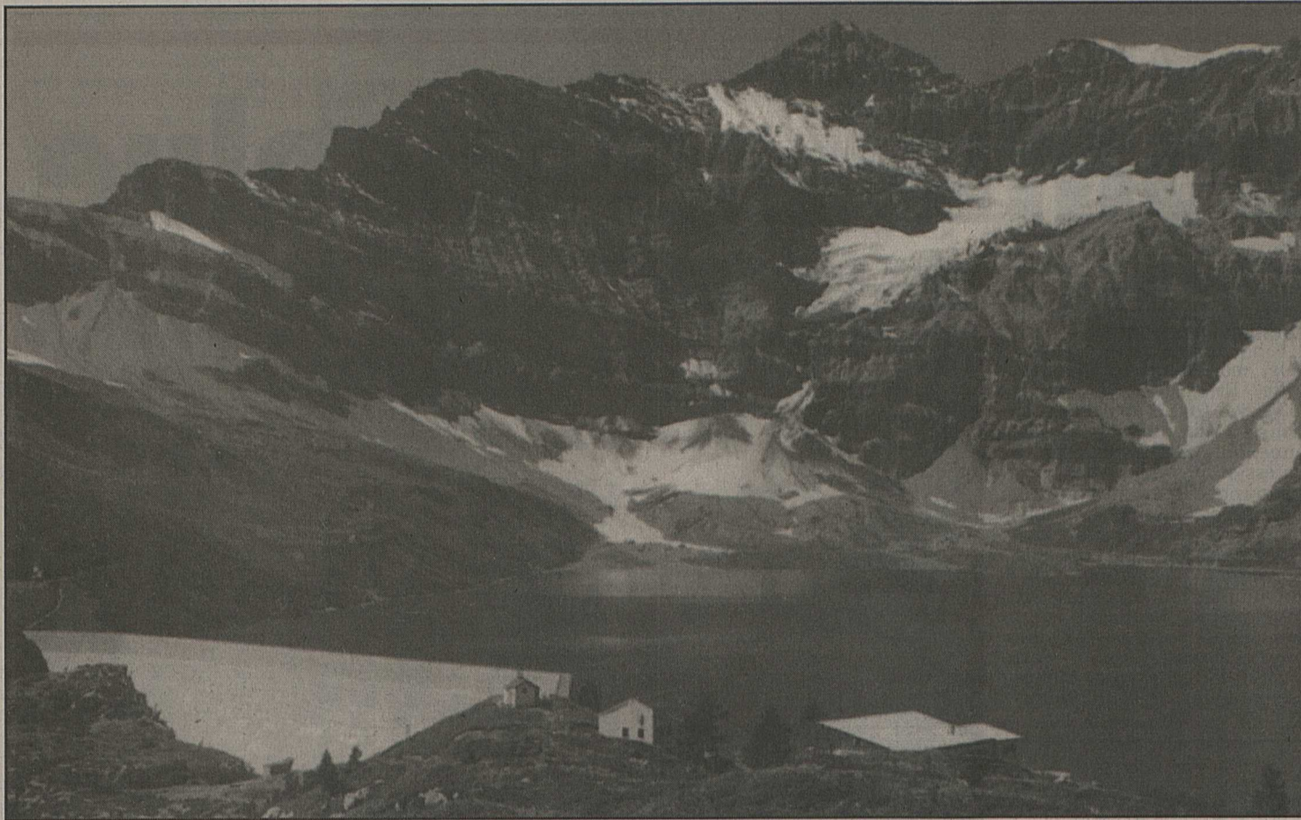
Les travaux d'étanchéité se poursuivent sous la cuvette de Salanfe nous apprend la société dans son dernier rapport de gestion.
