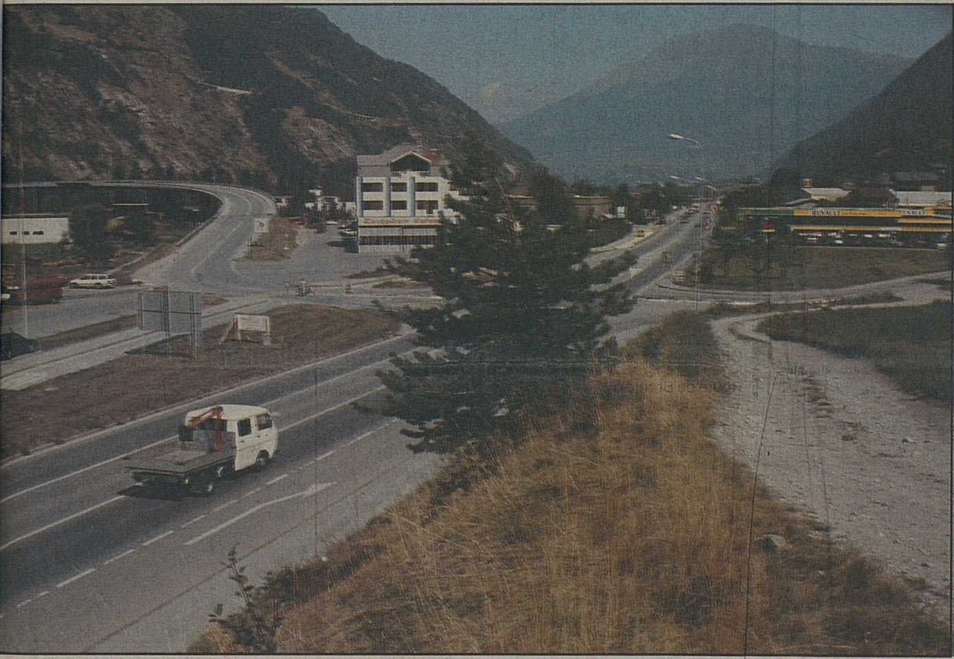
À gauche le pont de Lalden, avec le départ de la route de contournement. À droite, le village d'Eyholz: l'autoroute passera devant, mais sera enterrée.
