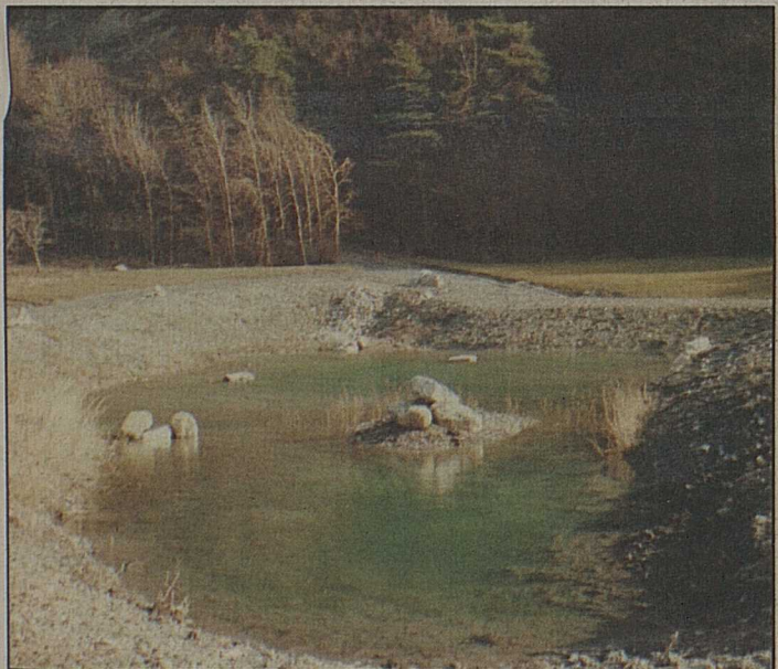
Un bel exemple de réalisation de biotope humide: l'étang des Maladaires (état mars 1993) à Sion recréé par l'Office des constructions fédérales en compensation de travaux pour l'OFAEM.
