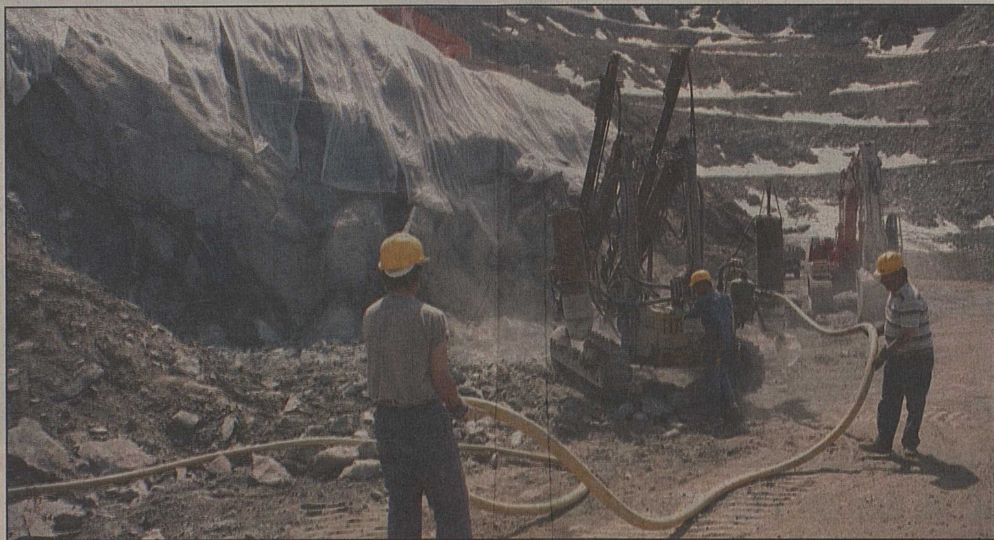
Un grand téléphérique aboutira au pied du barrage de la Grande Dixence. On prépare ici les soubassements de la gare supérieure.
