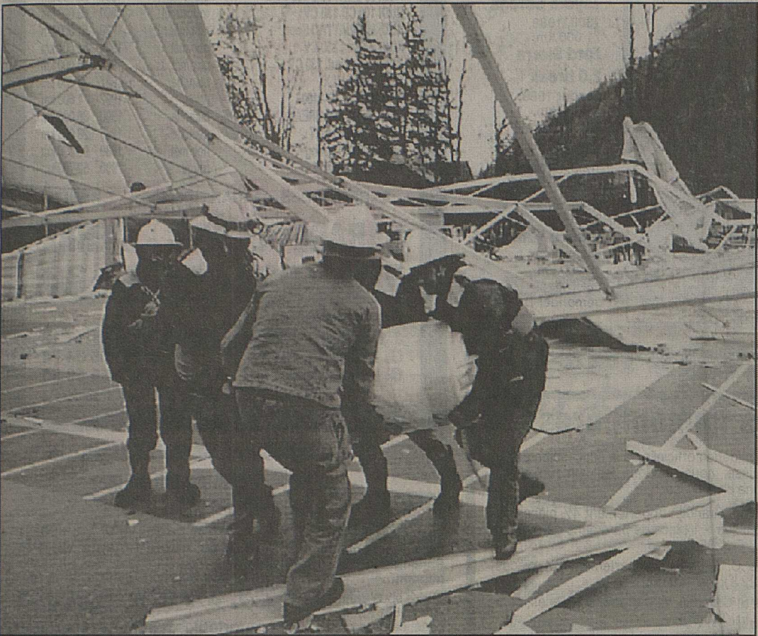
Peu après l'effondrement du chapiteau, les pompiers s'affairent dans les décombres. Lors de l'incident, 200 à 300 personnes se trouvaient sous la tente.
