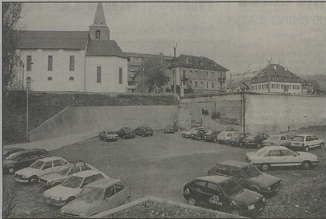
A cet emplacement est prévue la construction des écoles d'informatique et de tourisme.
