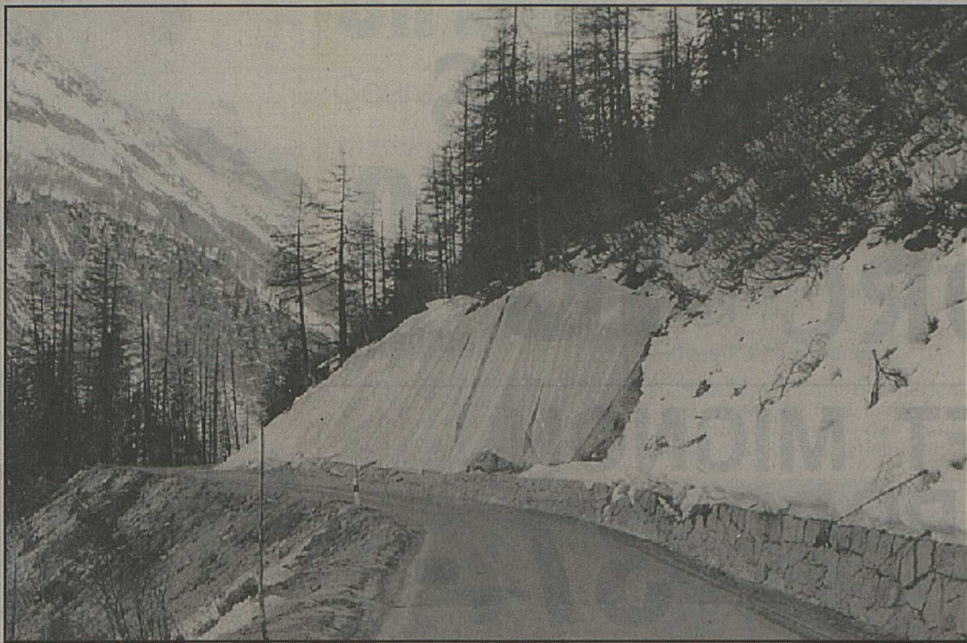
Les travaux ont débuté en automne dernier avec la mise en chantier de la galerie de la Perire. nf
