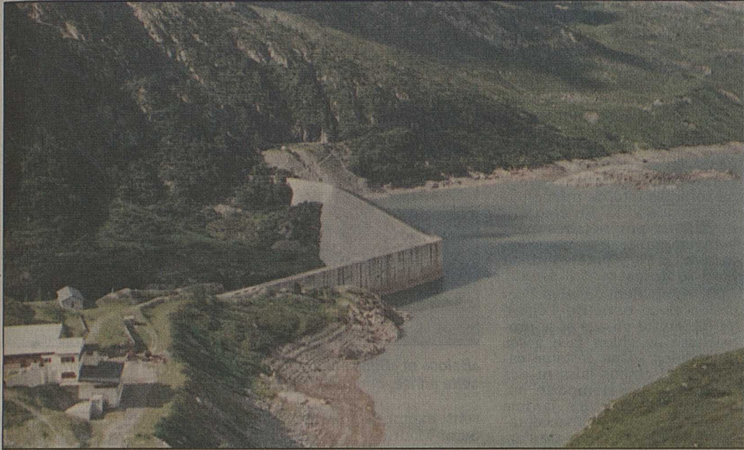
A la suite du chantier actuel qui colmate le lac, EOS va vider Salanfe.
