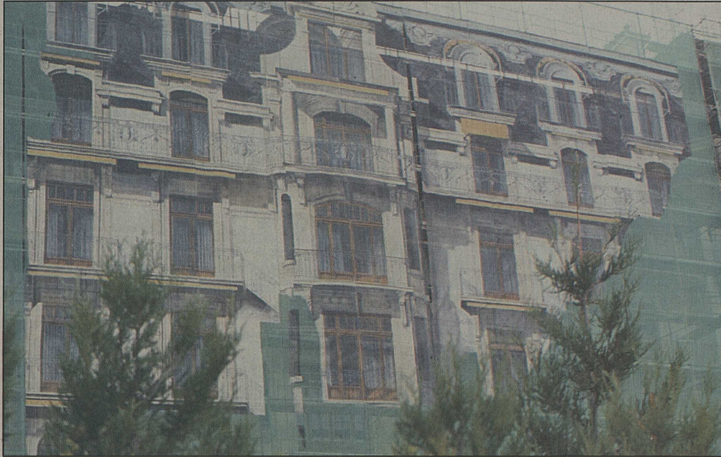
Le Beau-Rivage Palace d'Ouchy en pleine rénovation
