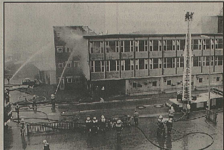
De gros dégâts pour Bally.
