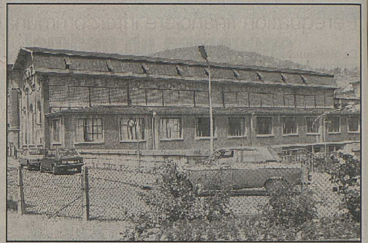
Les ACMV font partie désormais du passé.
