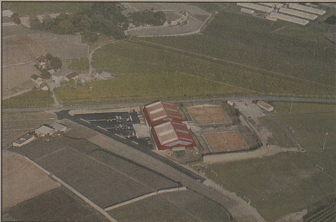
Une vue aérienne du centre sportif de Pont-Chalais près de Noës sur la commune de Sierre.
