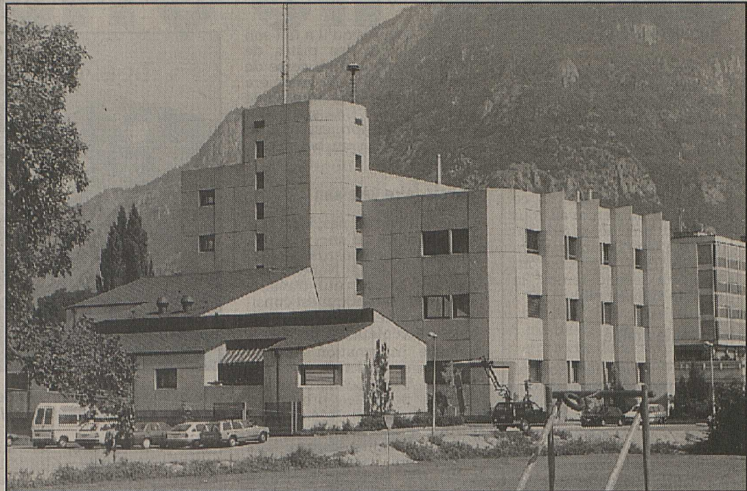
Le central téléphonique de Martigny: c'est dans ce bâtiment qu'a été aménagé le «télécom-shop».
