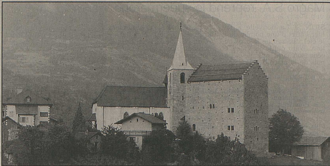
La restauration a été menée dans les règles de l'art.
