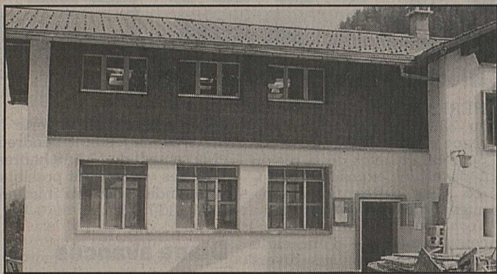
Les travaux intérieurs viennent d'être entamés.
