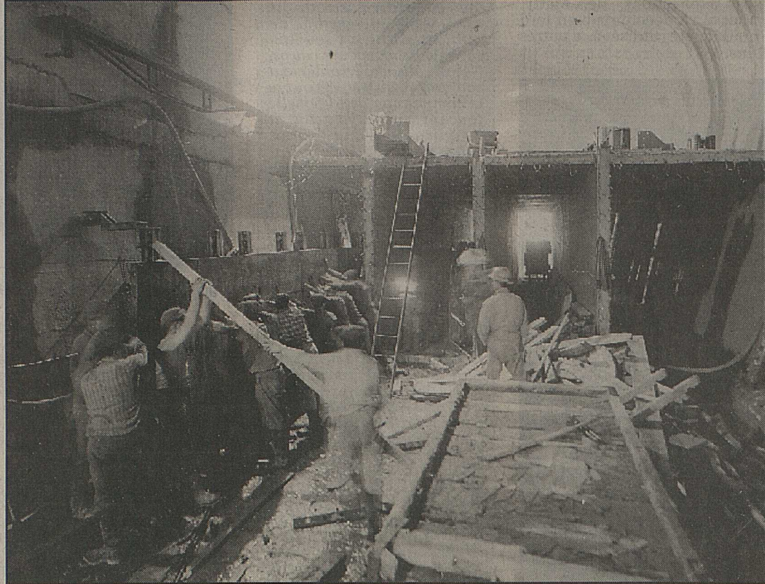
La construction du tunnel du Mont-Blanc: une atmosphère étouffante.
