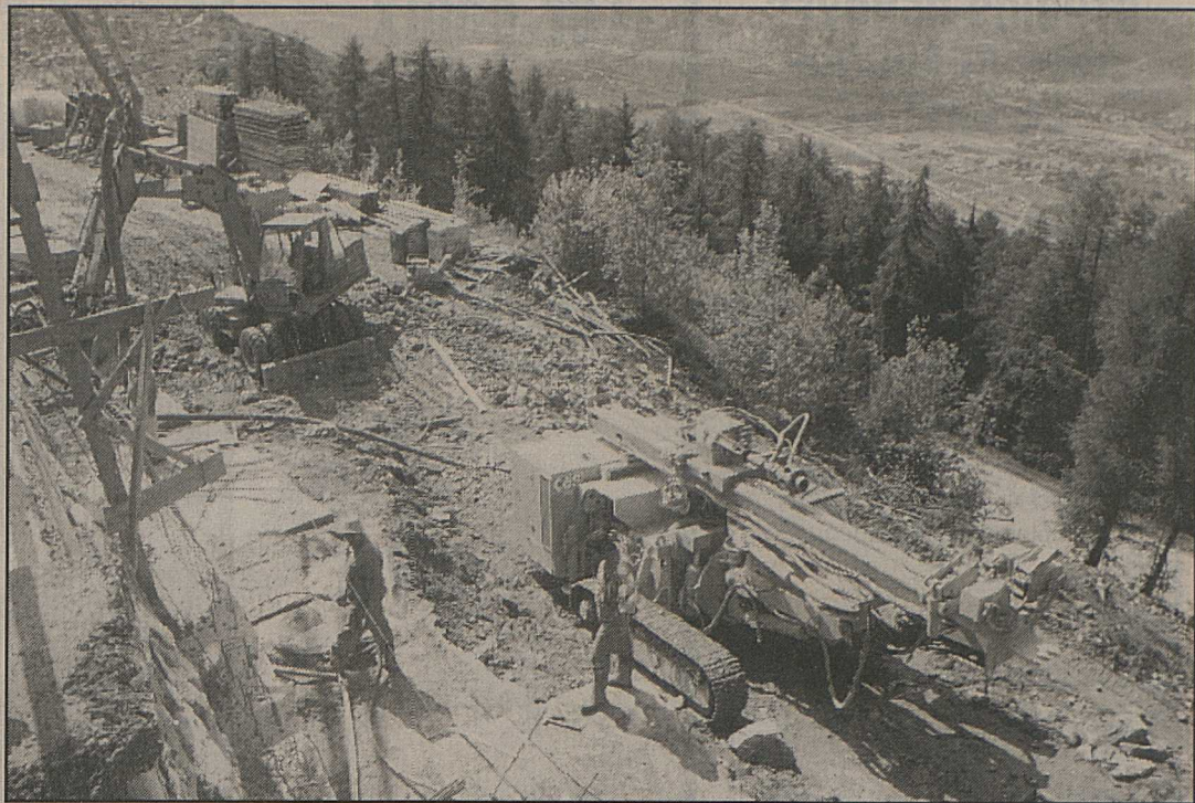
Les travaux de construction du parking de 420 places ont commencé.
