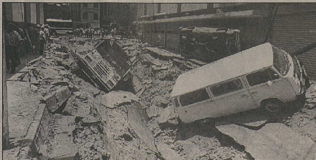
Les neuf explosions se sont produites dans les égouts, éventrant les rues du quartier.
