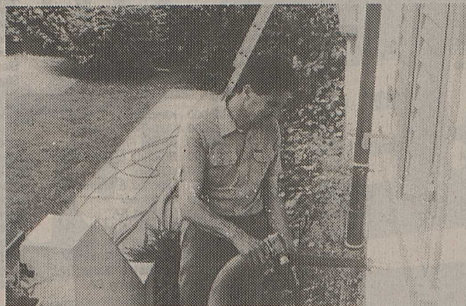
Olivier Aymon surveillant le fonctionnement du pistolet d'injection automatique de flocons de fibre. (Photo: NF 29.7.82).
