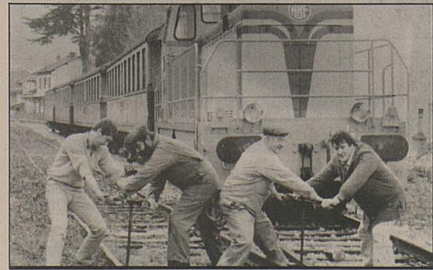
Le diesel-RBE en tête d'une rame de quatre anciens wagons (nouvelle acquisition en location pour le RBE qui rénovera l'extérieur des wagons) sur la voie principale à l'entrée de l'aiguillage où les volontaires s'activent à remettre en état traverses et voies. Ce sera une voie de garage pour le matériel roulant du RBE en gare de Saint-Gingolph. nf
