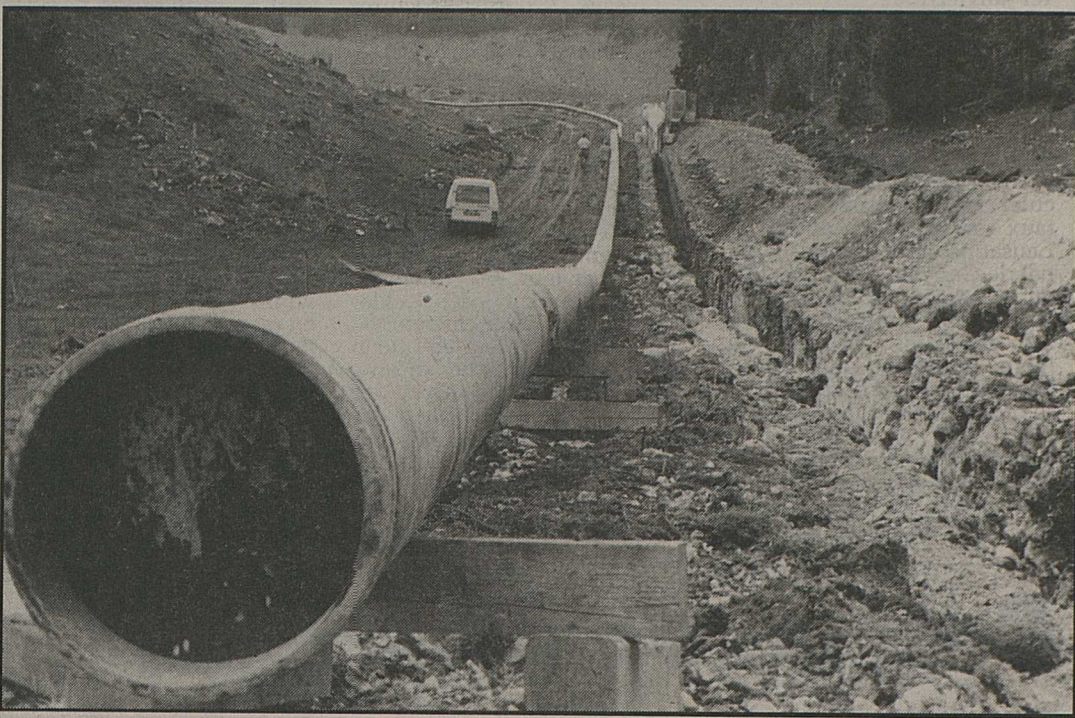
La construction d'un gazoduc dans la région jurassienne.
