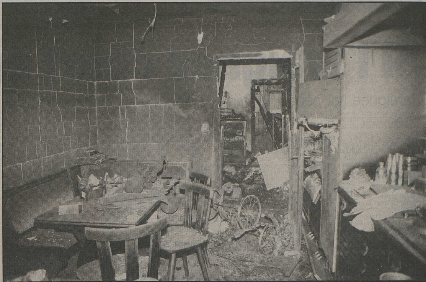
Occupé par une famille de réfugiés chiliens, l'appartement est entièrement détruit.
