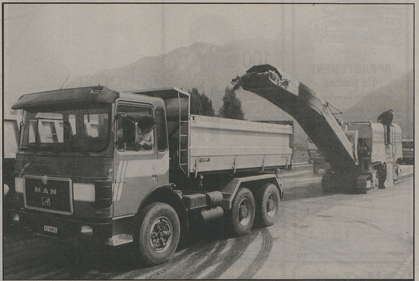
La «raborteuse» géante en service sur la transversale Hérens-Platta.
