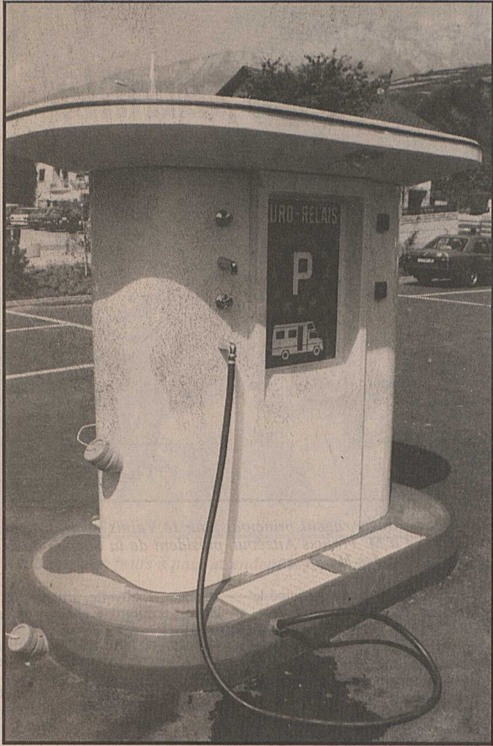
L'Euro-Relais de Saint-Léonard, installé par la Municipalité sur le parc du lac souterrain. Une dizaine de véhicules peuvent s'y ravitailler, évacuer leurs eaux usées à l'égout communal et y stationner durant une ou deux nuits.
