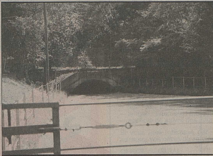
Entrée de la galerie actuelle: le tracé sera modifié vers la gauche pour accéder à la nouvelle galerie.
