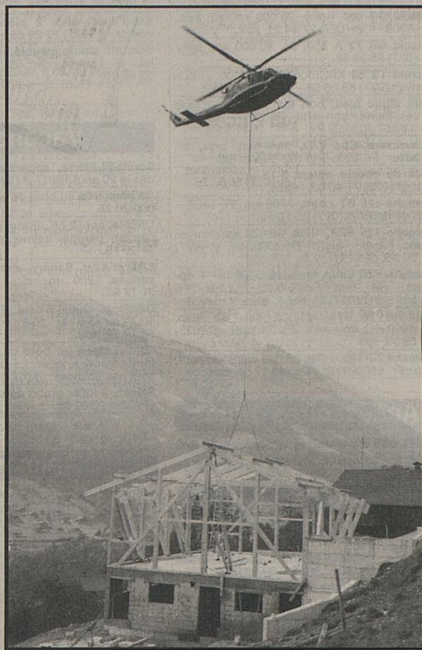
L'hélicoptère, le seul moyen adéquat pour construire rapidement et rationnellement une ferme de montage difficilement accessible des voies normales de communication.
