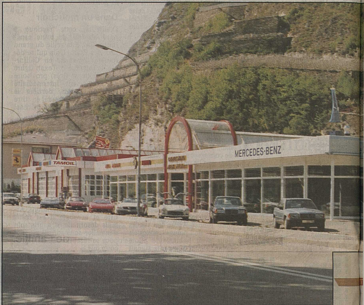
Bureau d'architecture Antoine de Lavallaz, bureau d'ingénieurs Jacques Bonvin et Jacques Bertholet, étude électrique Pierre-Etienne Roux, étude technique Gaston Haenni
