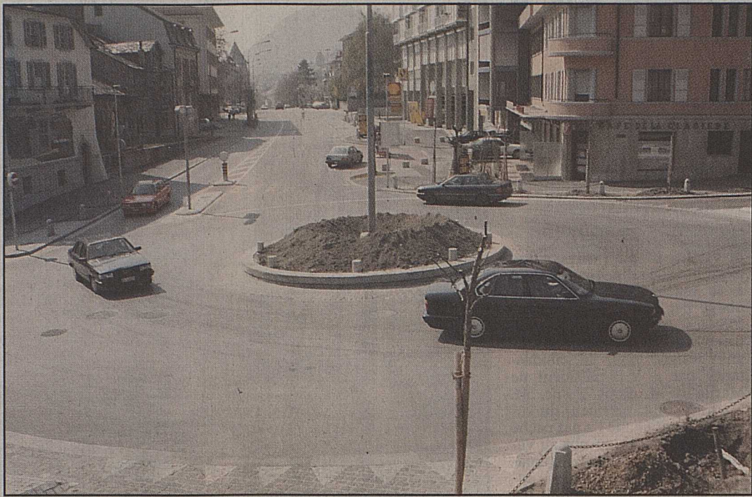
Dans le giratoire de Sion-Nord (Grand-Pont - avenue Ritz), la manœuvre de «demi-tour» est une possibilité particulièrement intéressante. L'usager qui rate la sortie sur Ayent ou sur la route de Loèche tourne une nouvelle fois sur l'anneau sans perdre de temps.
