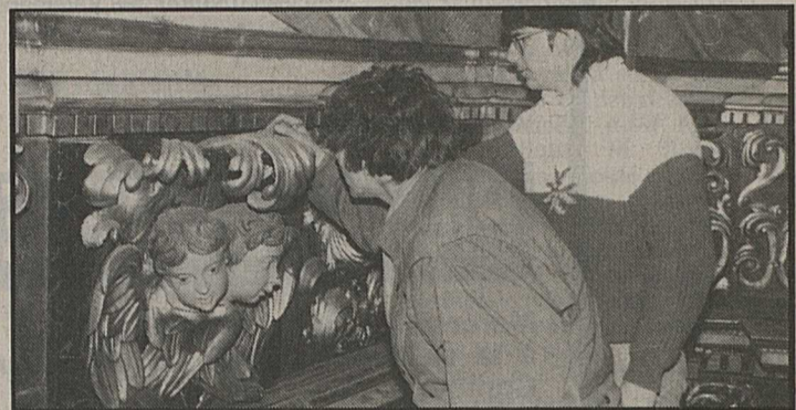
La réfection des niches, des piliers et des médaillons nécessite des soins méticuleux.
