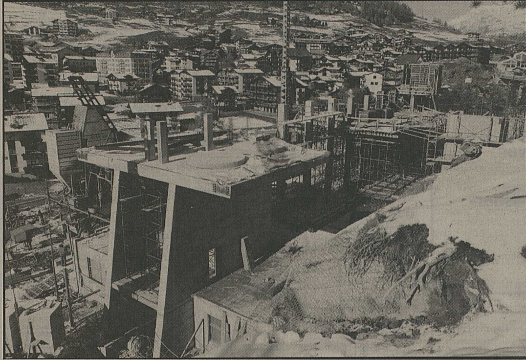
La station aval de l'Alpin Express de Saas-Fee. L'inauguration de la nouvelle installation devrait avoir lieu à la fin de cette année.
